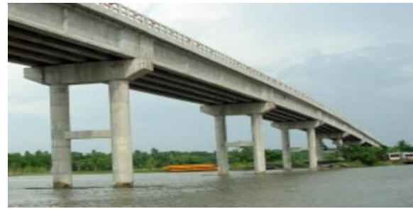
(d) Kanchan Bridge: Concrete beam bridge
